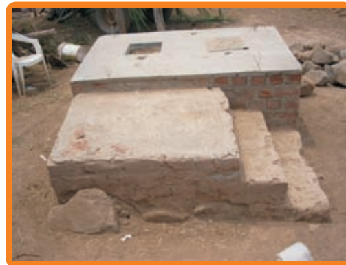
Cámara terminada lista para la taza y caseta
