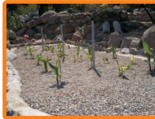
FIGURA N° 19. Segunda fase de instalación del humedal A. Colocación de los sustratos; B. Siembra de plantas.
