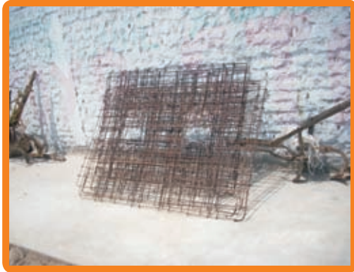
Parrilla de acero para losa
