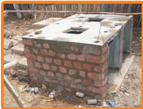
Dos cámaras con ladrillo revestido
