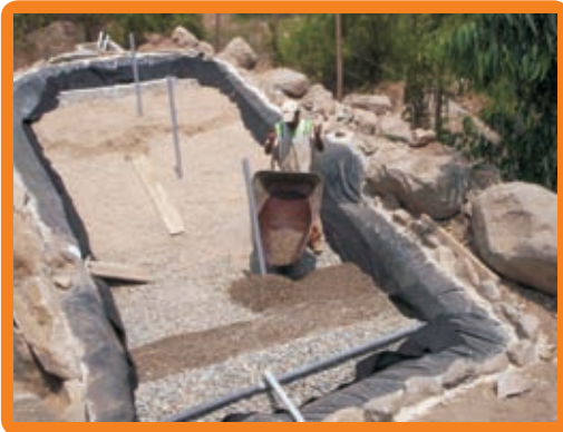
FIGURA N° 19. Segunda fase de instalación del humedal A. Colocación de los sustratos; B. Siembra de plantas.
