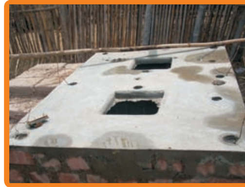
Cámara terminada lista para la taza y caseta
